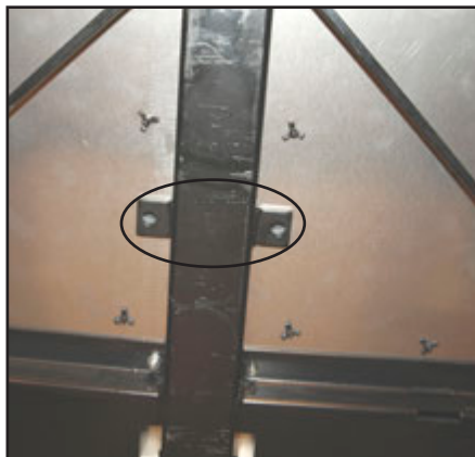
Bor to huller op igennem bundpladen med de viste huller som skabelon.
